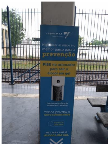
Figura 5.16 SuperVia – Estação Saracuruna – 06/03/2021
