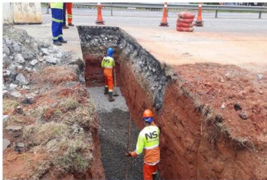
Figura 6.5 Via Lagos - Ampliação de Drenagem
