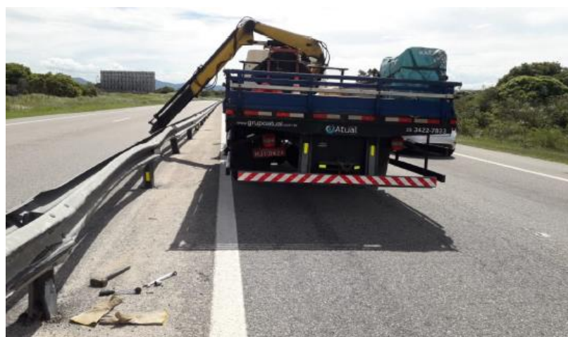
Figura 6.7 Via Lagos – Dispositivo de segurança
