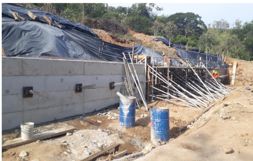
Figura 6.3 Via Lagos - Recuperação de Talude 2
