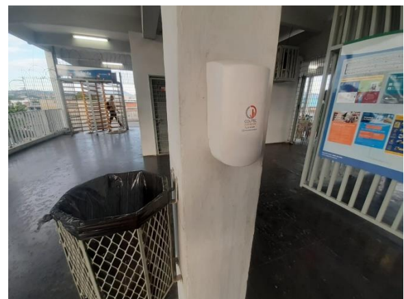
Figura 5.20 SuperVia – Estação Pavuna – 11/03/2021
