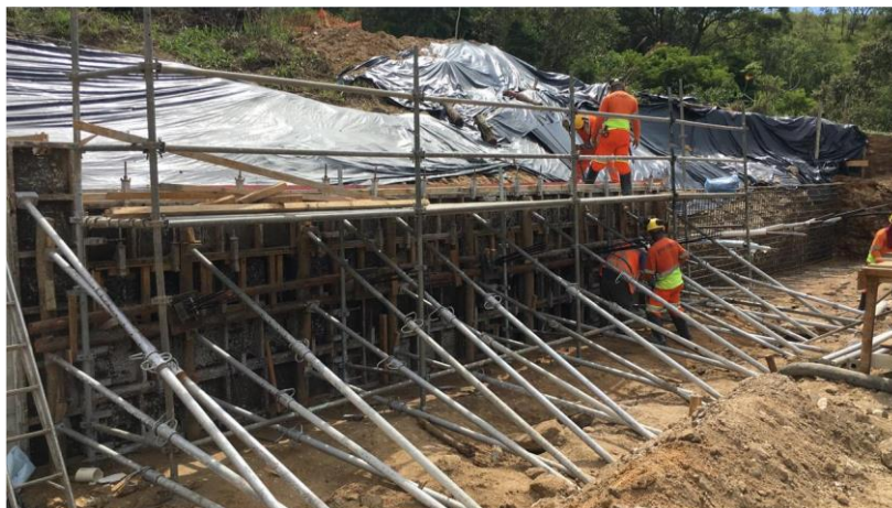
Figura 6.2 Via Lagos - Recuperação de Talude
