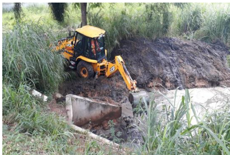
Figura 6.10 ViaLagos - Limpeza de bueiro
