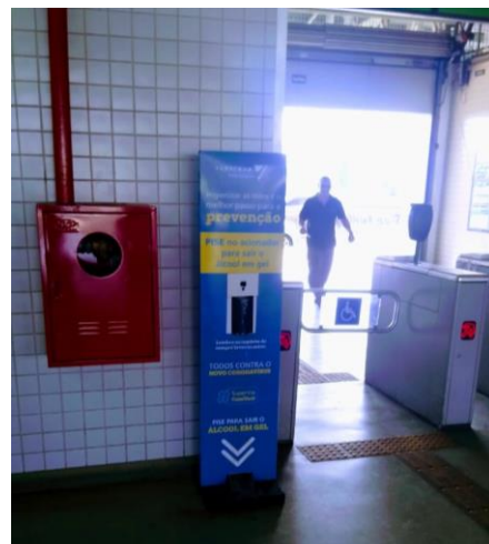
Figura 5.32 SuperVia – Estação Deodoro – 23/03/2021
