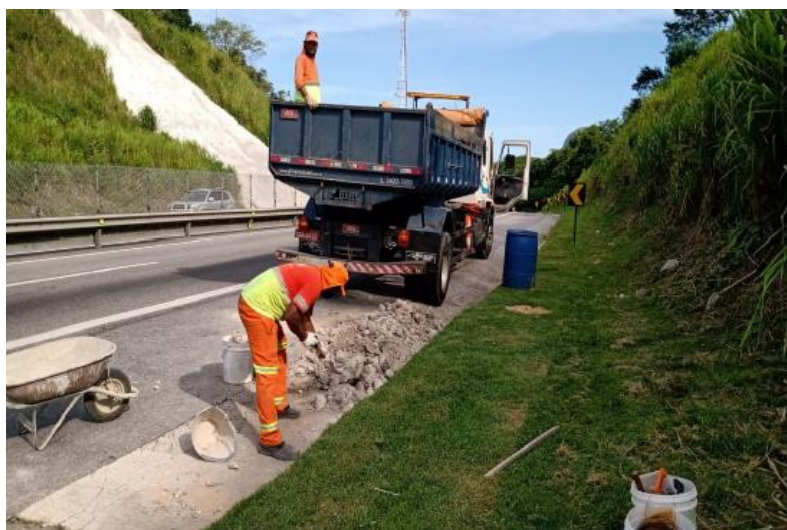
Figura 6.6 Via Lagos - Recuperação de sarjeta
