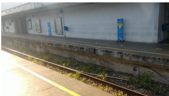
Figura 5.24 SuperVia – Estação Campo Grande – 14/03/2021
